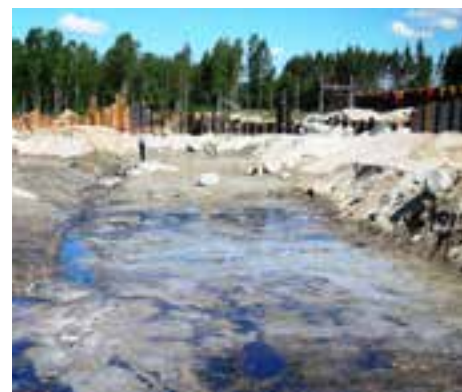
Et material- og impregneringsanlegg i Elnaryd renses for arsenikk og kreosot.
